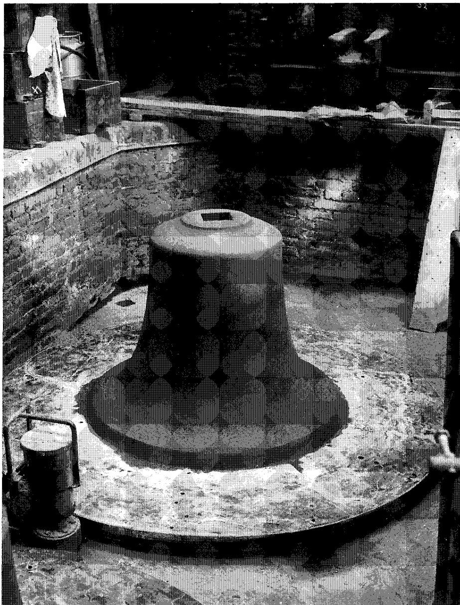
Afb. 338: De voltooide kern wordt verkregen door over de stenen kern een dun laagje cementzand aan te brengen dat met behulp van de binnenmal tot de juiste vorm wordt gemodelleerd (foto Eijsbouts Asten)
