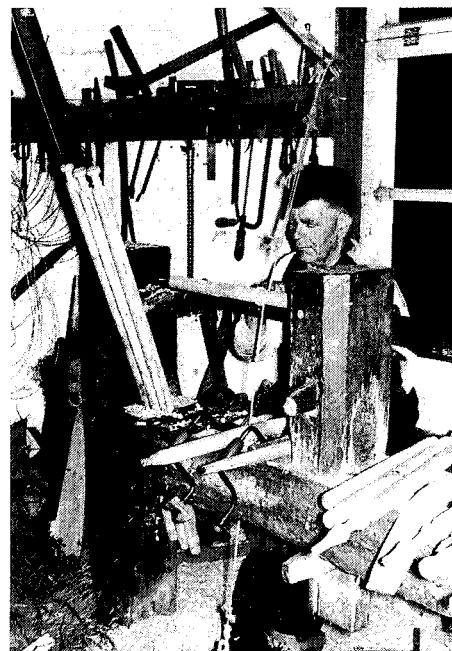
Afb. 165: Op deze foto (uit scriptie Donkers) van de primitieve houtdraaibank met „wip”-constructie met staak (zie afb. 163, type A) van stoeldraaier Van der Pas uit Heeswijk, ziet men de „losse kop” (zie afb. 163, A 3) heel duidelijk
