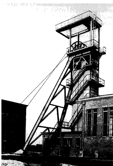
Afb. 69. schachtbok, schachttoren
