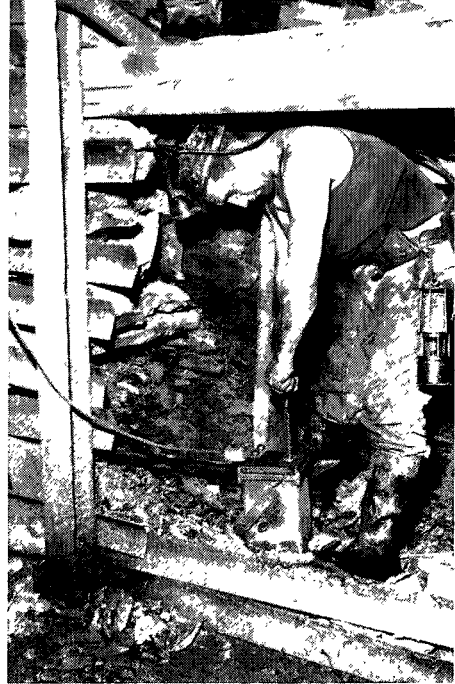
Afb. 32. schiethouwer in schuilnis tijdens het ontsteken; rechts een veiligheidslamp
