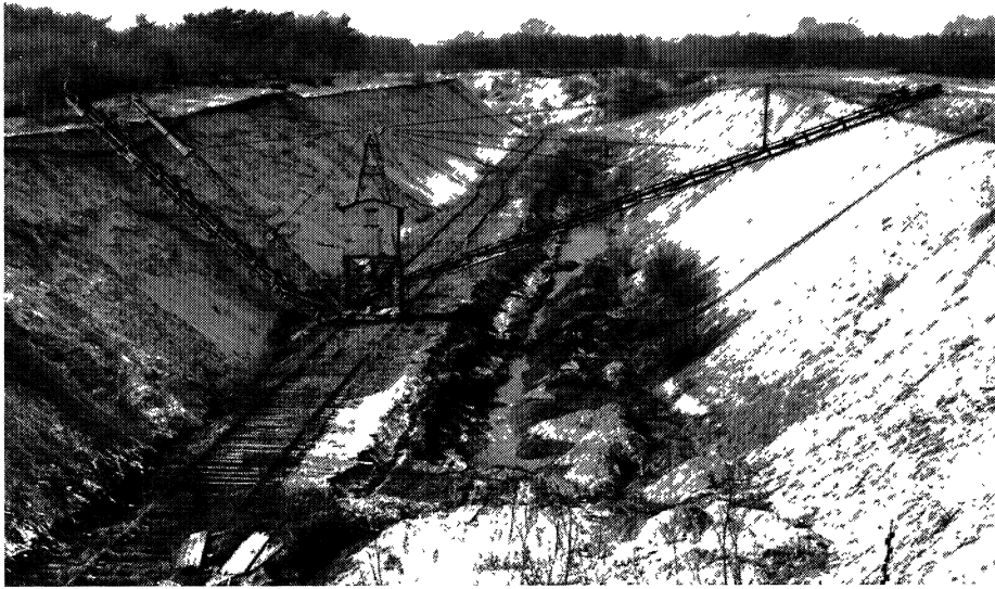
Afb. 31. groeve met excavateur voor de winning van klei voor de dakpannenindustrie te Tegelen
