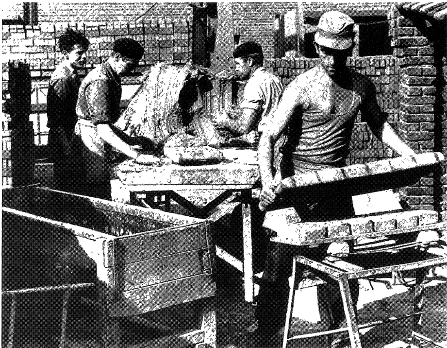
Afb. 20. het vormen van handstenen te Echt (1965); links op de voorgrond de zandbak, rechts de klapstoel waarop juist een zesbaksvorm werd omgekeerd; op de achtergrond rechts de vormer, links vóór de vormer op de vormtafel de afstrijkboog
