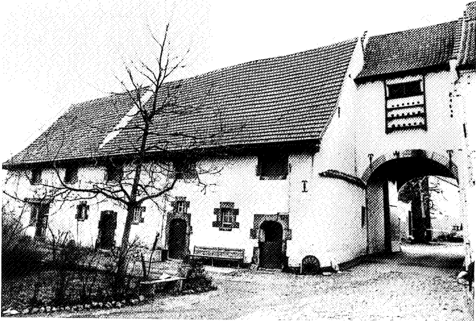
Afb. 17. Duivenhok en duivenslag in het poortgebouw (foto van het klooster van Kolen in Kerniel (Q 152) door A. Lambrechts in december 1973; doc. Bokrijk)
